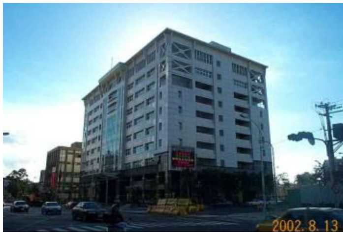
板橋稅捐處大樓
